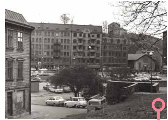
Skanstorget sett från Skansbergets nordöstra fot. Bilden är tagen på 1970-talet och visar ett äldre landshövdingehus som ska rivas. Vid den här tiden liknar torget dagens Skanstorget.
